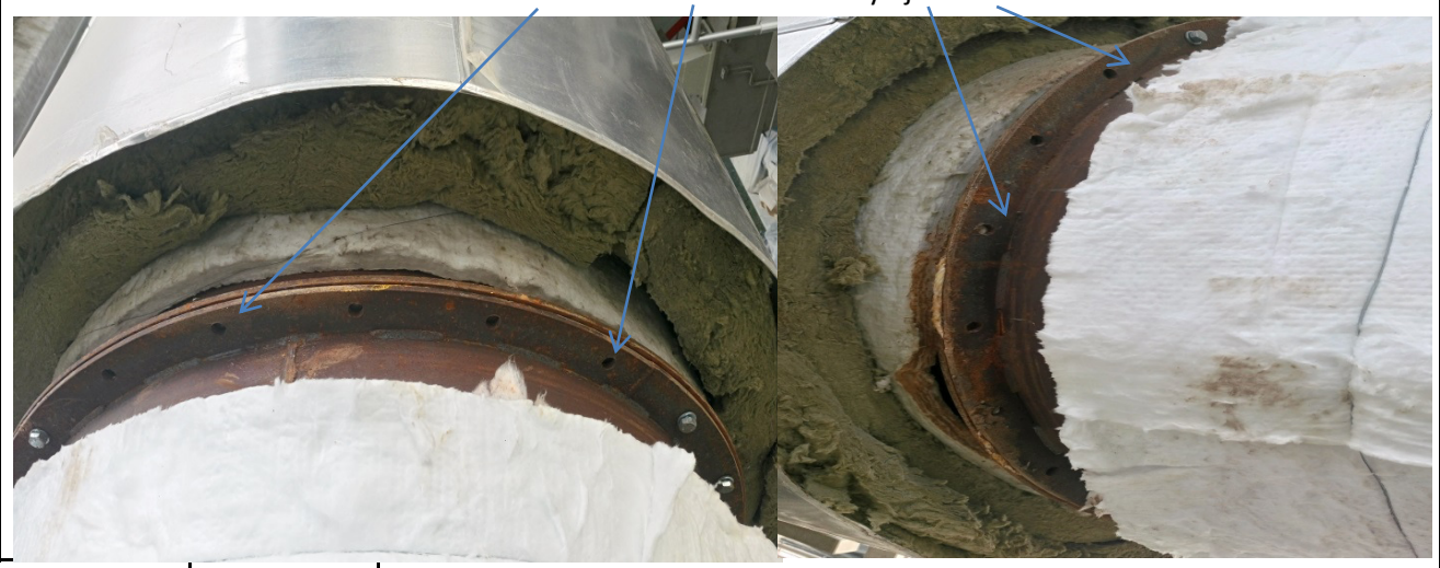
Secciones de conductos donde faltan bulones y ajustes de los mismos
