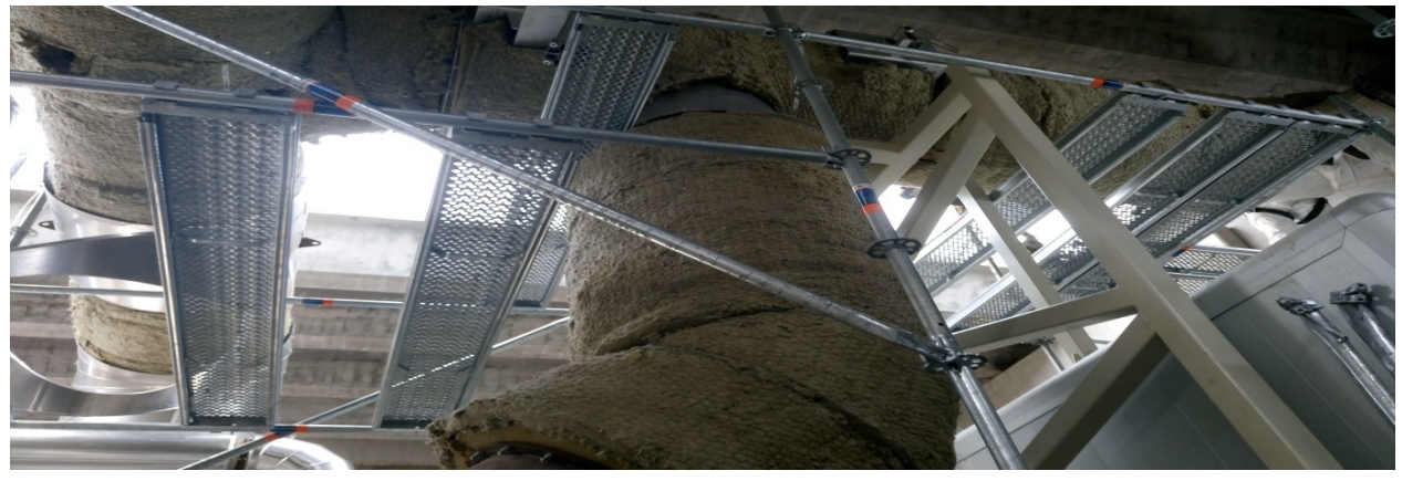
Secciones de conductos donde faltan bulones y ajustes de los mismos
