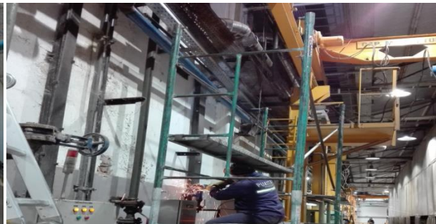
2 - MONTAJE DE ACOMETIDAS NUEVAS EN HIERRO NEGRO
