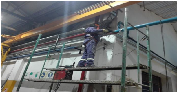
1 - DESMONTAJE CAÑERÍA DE 2"
