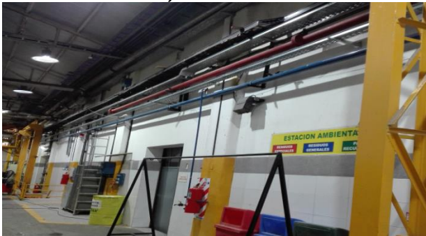
3 - CONSTRUCCION Y MONTAJE DE TRAMO PRINCIPAL DE CAÑERÍA DE AIRE COMPRIMIDO EN 3"
