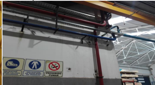
3 - CONSTRUCCION Y MONTAJE DE TRAMO PRINCIPAL DE CAÑERÍA DE AIRE COMPRIMIDO EN 3"
