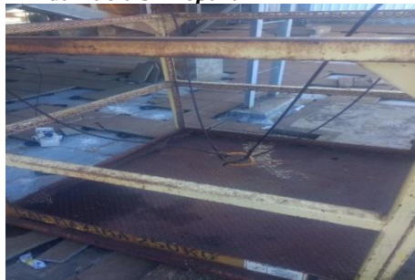
2-Guindola en reparación desmontaje de malla
