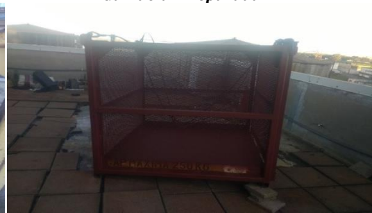
2-Guindola en reparación desmontaje de malla
