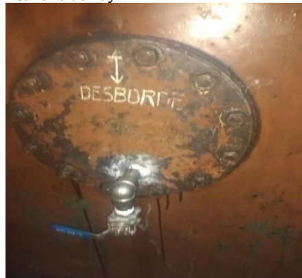
3 Fabricación y Montaje de derivación
