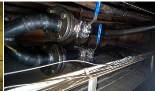
2 Modificación de tapa con válvula
