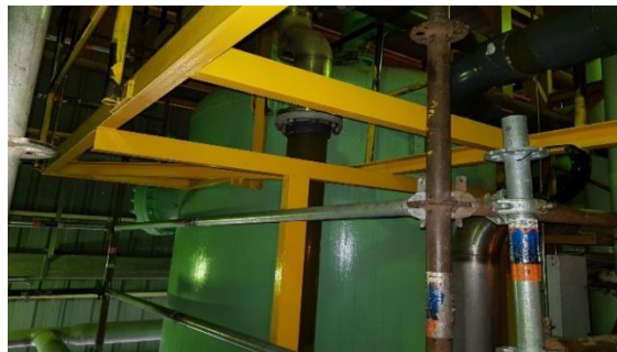
3 - PLATAFORMA MONTADA Y PINTADA
