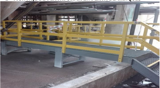
2 - PLATAFORMAS MONTADAS Y ABROCADAS
