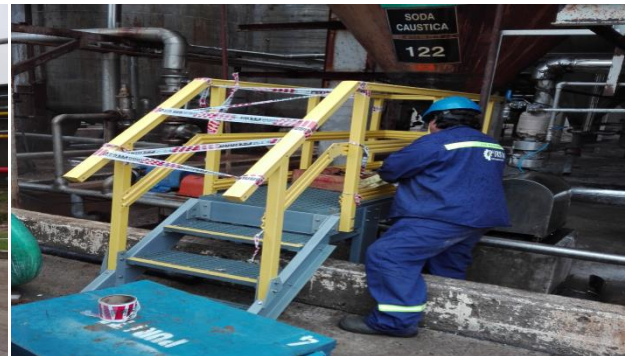
2 - MONTAJE DE PLATAFORMA EN PLAYA DE TANQUES
