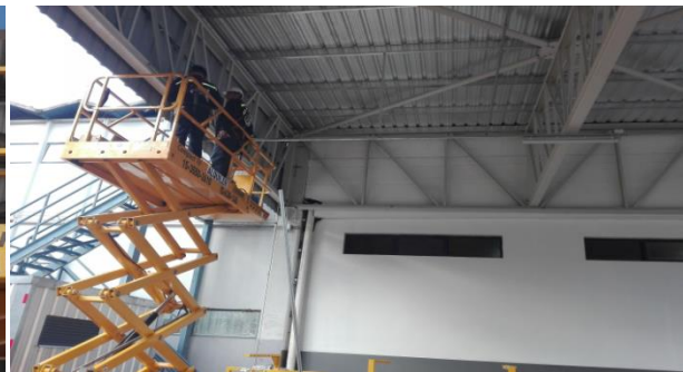
1 – Montaje de cañerías y cableado para la instalación eléctrica
