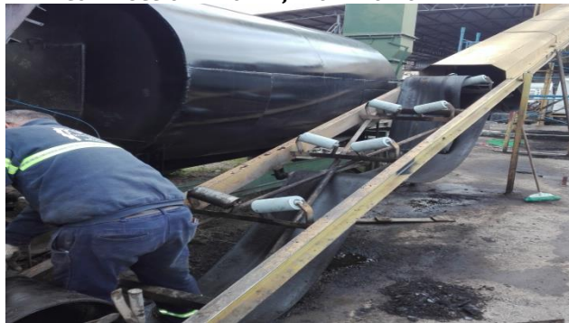
3 - CONSTRUCCION Y MONTAJE RODILLOS CUNA BASE Y RETORNO CON RASCADORES
