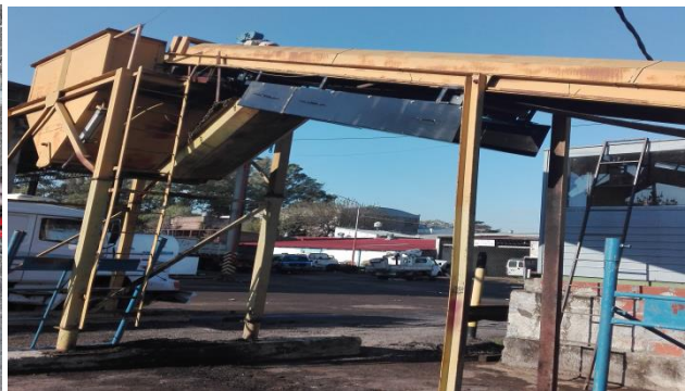
2 - REPARACION GENERAL EQUIPO TRANSPORTADOR
