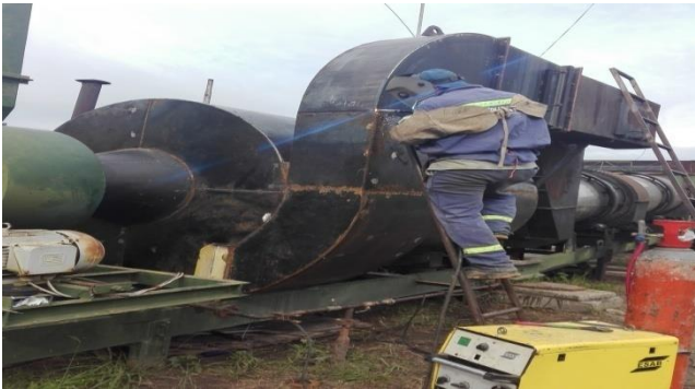
4 – Soldado de paneles de chapa sistema MIG
