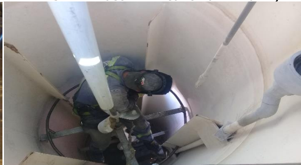
- MONTAJE EN INTERIOR DEL TANQUE
